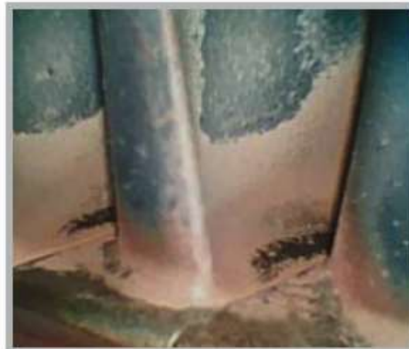
Contrôle de la corrosion
