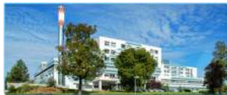
Centre de chirurgie orthopédique et de la main
