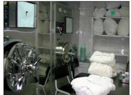
Photo 2 Stérilisation, Mehrad Hospital, Téhéran.
