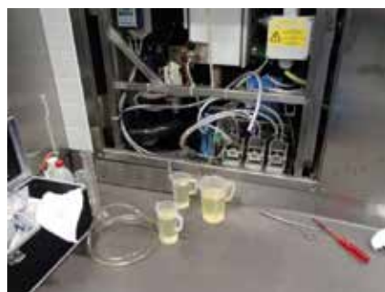
Absaugen vor der Dosierpumpe
