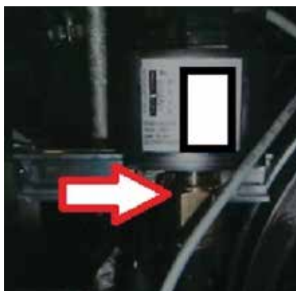
Avant : matériel inadéquat (laiton)
