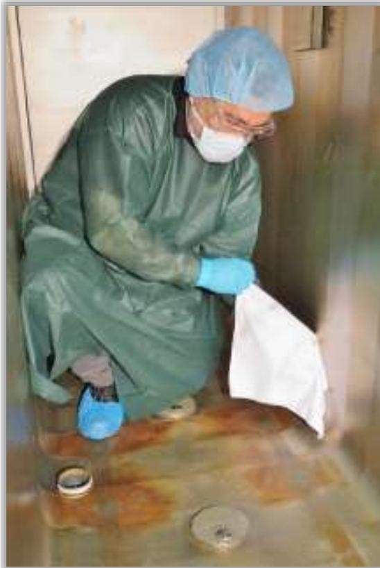
Rouge wird manuell, mechanisch (z.B. Schleifen, Elektropolieren) von einem Mitarbeiter entfernt
